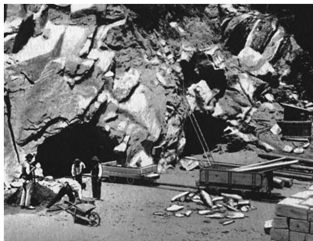
Début des travaux du tunnel du Simplon
